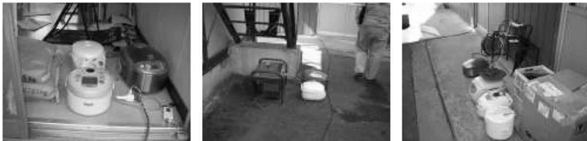
1度に8器を。発電機をフル稼働(3/13,14)
